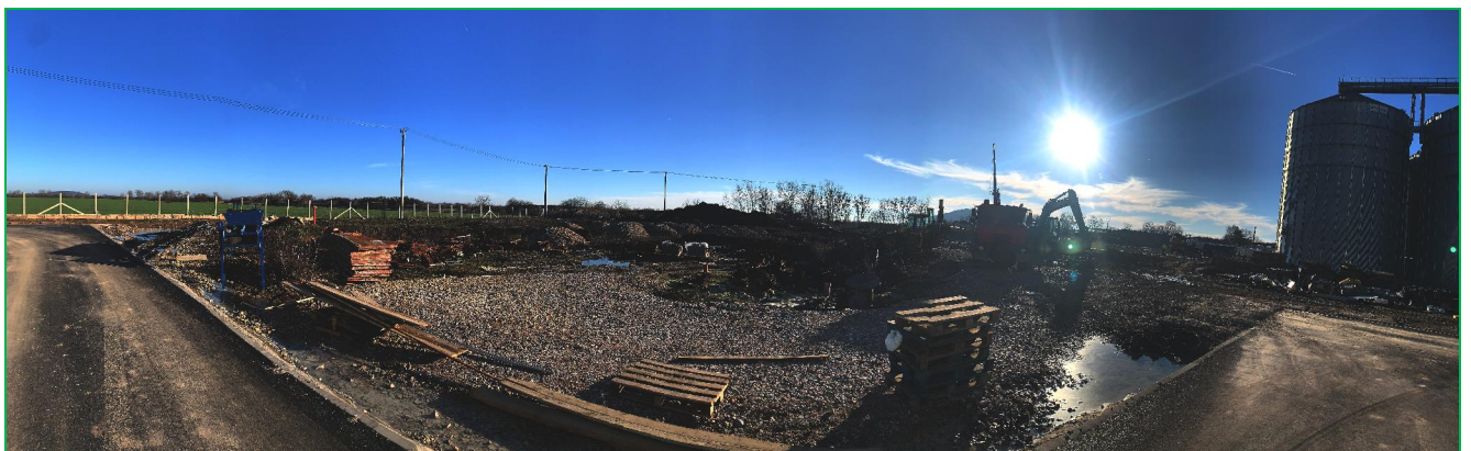
Obr. 3.3 Pohľad na záujmové územie v mieste výstavby
