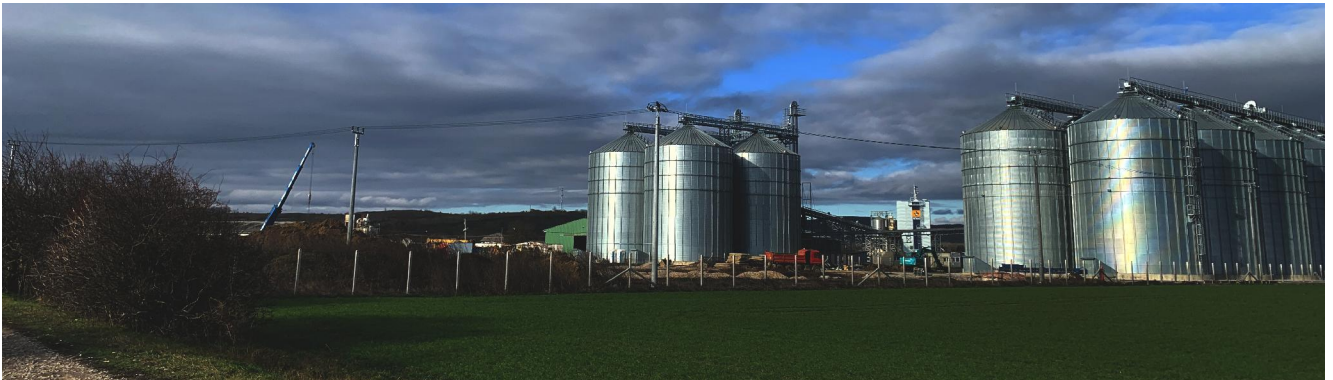
Obr. 3.4 Pohľad na záujmové územie z juhovýchodnej strany
